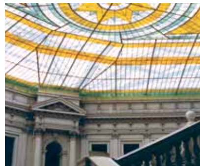
Techo acristalado con placas Lexan Thermoclear Universidad de Varsovia
