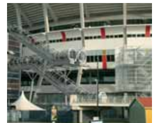
Amsterdam Arena eligió la placa Lexan Solar Control IR* para acristalar los túneles de las escaleras del ala cuatro del estadio
