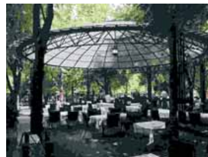
Para la cubierta del restaurante Madera de Belgrado se eligió la placa Lexan Thermoclear por su excelente transmisión de la luz, su fácil instalación y la protección contra los rayos UV por ambos lados
