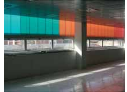
El sistema de placas Lexan Thermoclick se ha utilizado para la fachada de este edificio de Barcelona
