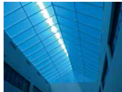
Para el acristalamiento del techo de este colegio de Al Wasel, UAE Dubai, se ha utilizado la placa Lexan Thermoclear Sun XP con protección contra los rayos UV por ambos lados
