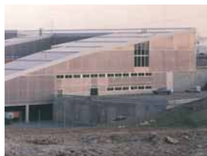
El despacho de arquitectos Abalos y Herreros eligió la placa Lexan Thermoclick* para el aplacado vertical de este edificio por su alta capacidad de transmisión de luz y sus propiedades de aislamiento térmico
